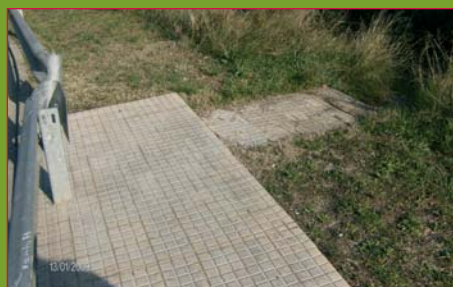
■ S'arranjaran les voreres en mal estat.
